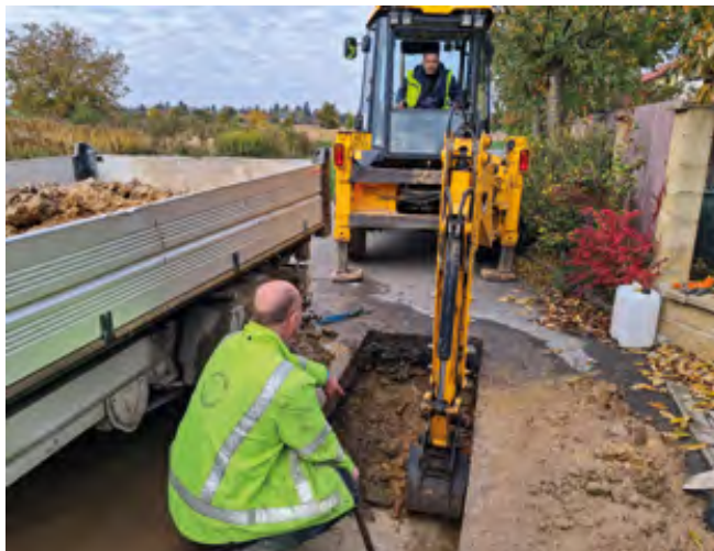
Páni Jiří a Radek z TS při výkopových pracích
