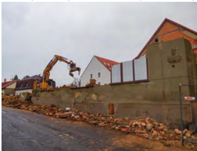
Demolice staré budovy restaurace
