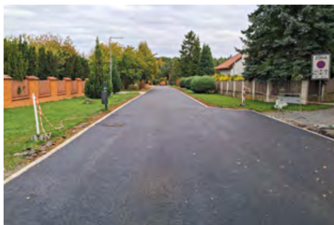
Hotová nová silnice v ulici Holekova
