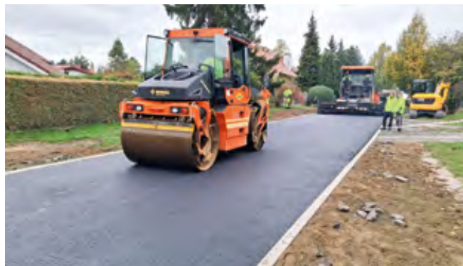
Pokládka nového asfaltu
