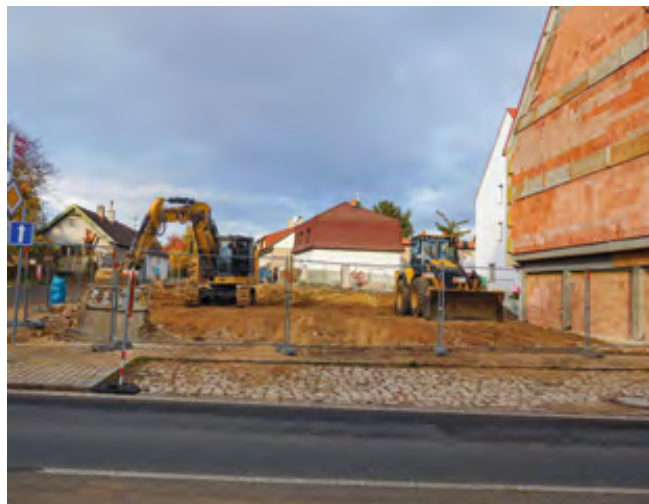
Místo po dokončení demolice
