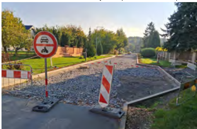
Napojení na původní silnici v ulici Holekova
