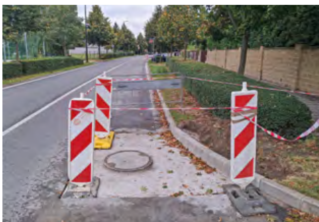
Kanalizační poklopy po opravě
