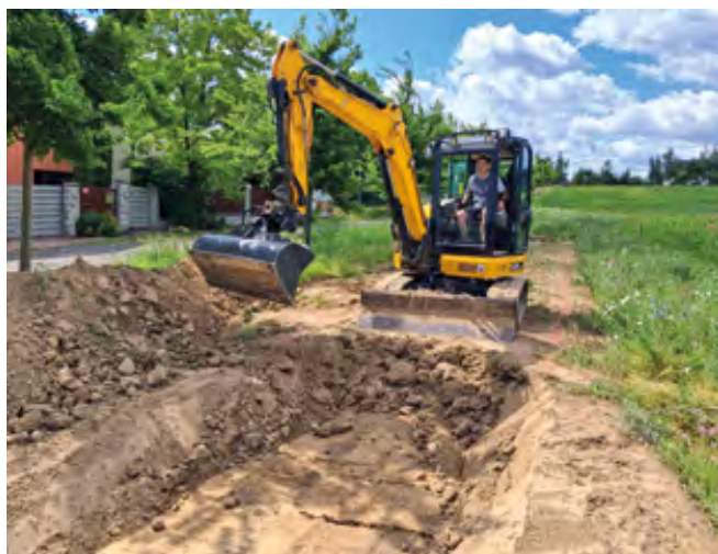
Pan Luděk z TS při bagrování příkopu
