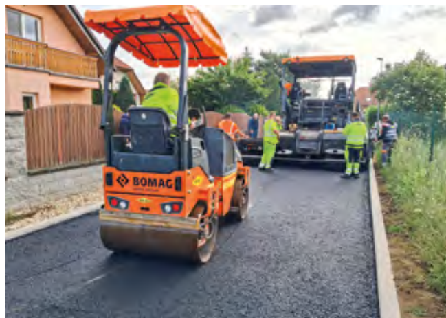
Pokládka nové asfaltové vozovky
