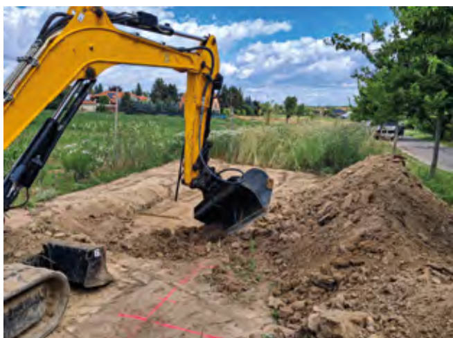
Nová část příkopu navazuje na původní část
