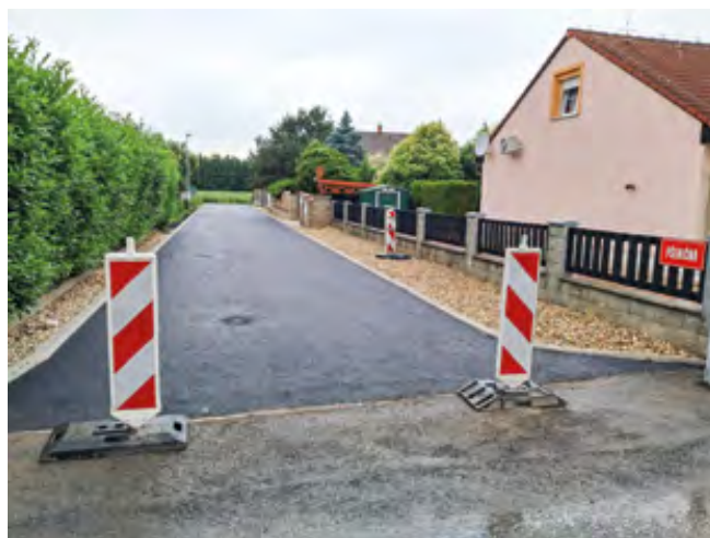
Ulice Pšeničná po rekonstrukci
