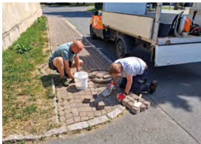
Páni Jan a Pavel z TS při opravě chodníku
