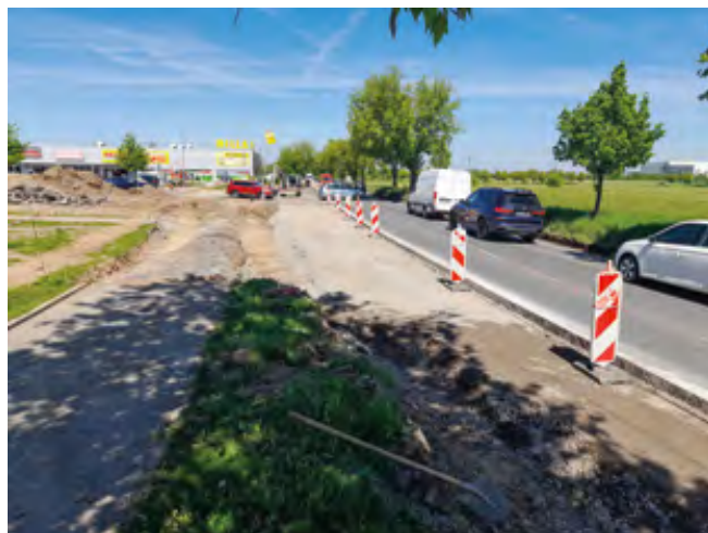
Výstavba nového přípojevacího pruhu k OC
