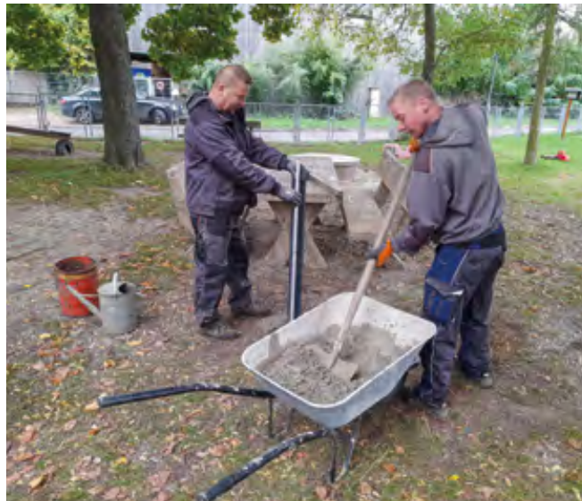
Pánové Jan a Jan při pečlivé instalaci nového koše
