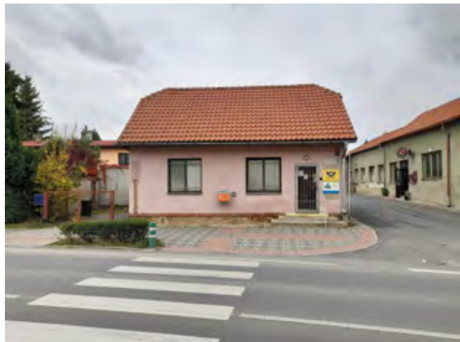
Budova pobočky ČP Šestajovice
