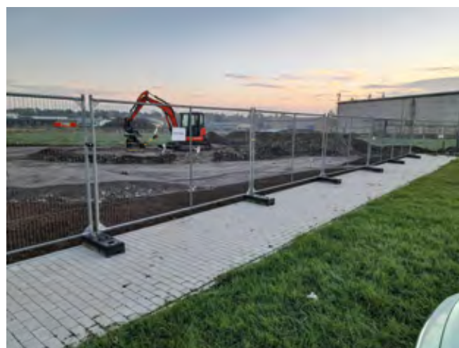
Budování základů nového skateparku
