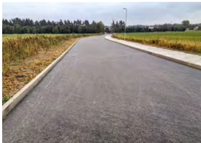
Dokončená nová komunikace v ulici Potoční
