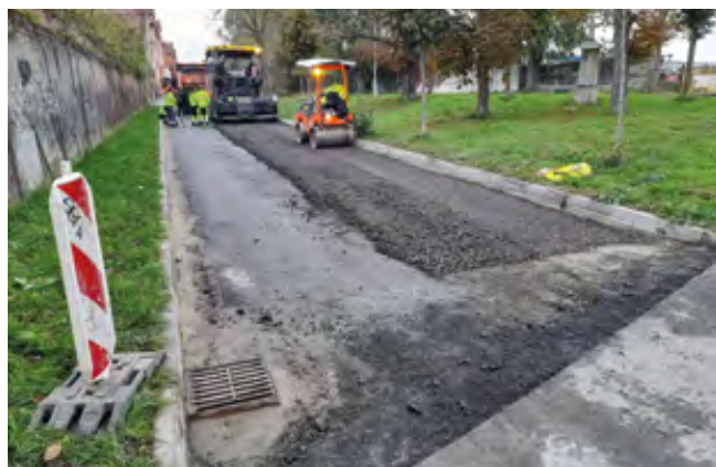
Budování základů napojení silnice Nad Údolím
