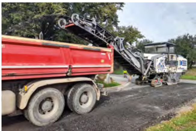
Frézování starého povrchu silnice v ulici Lipová
