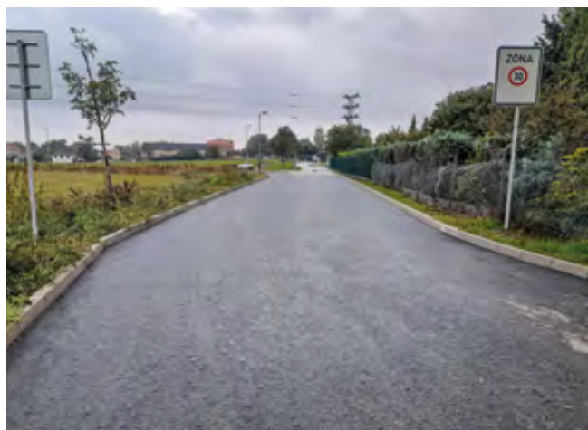
Nová komunikace v ulici Nad Údolím
