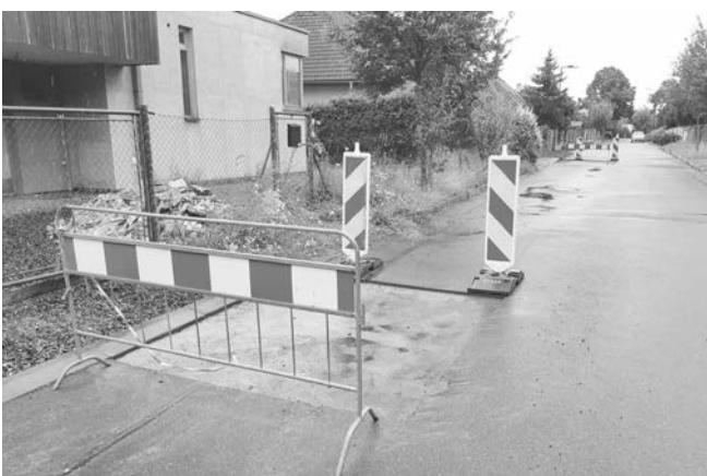
Připravený podklad pro asfalt na opravených místech silnice
