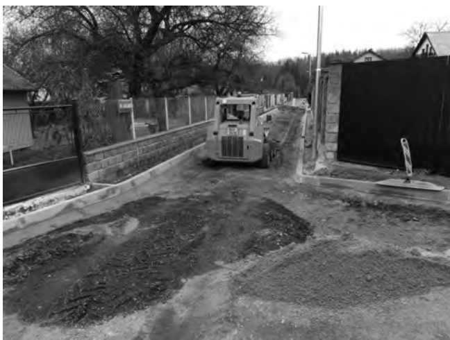
Rekonstrukce silnice v ulici Ve Skalkách
